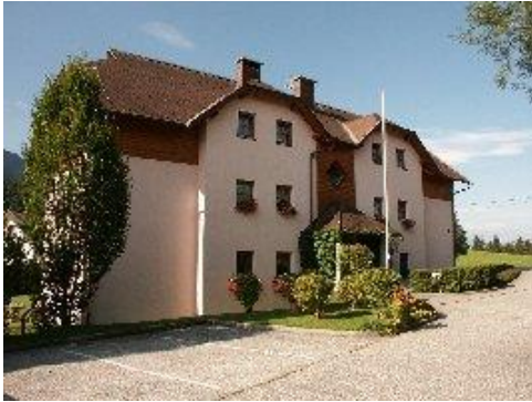
(Wohnhaus Neue Heimat - Haus A)
