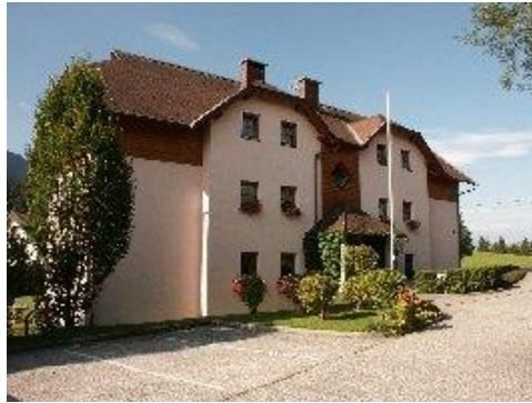
(Wohnhaus Neue Heimat - Haus A)
