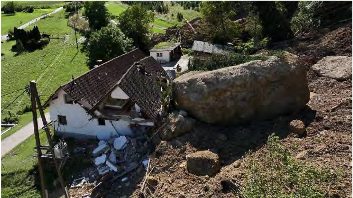
Abbildung 9: Felssturz in Rottenstein 1
